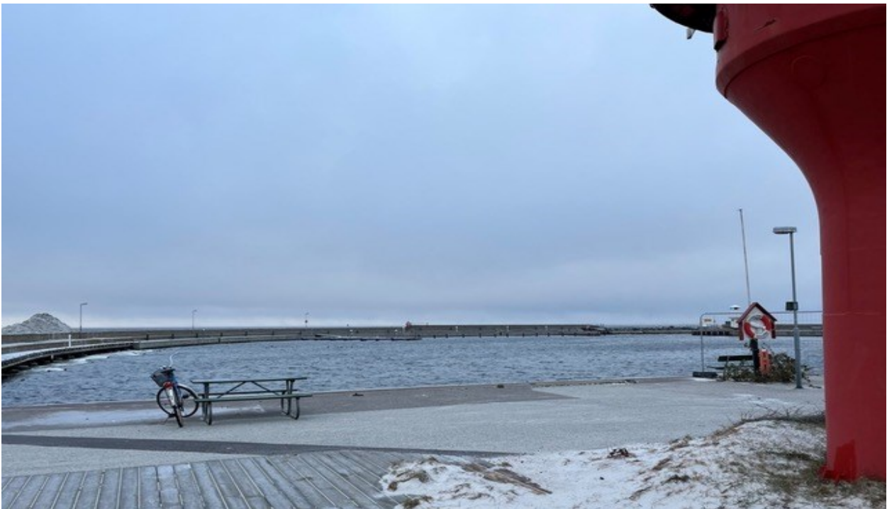
Skanörs hamn i december 2022. Till våren ska nya flytbryggor ligga på tvären över bassängen och en hel del annat kan vara förändrat.
