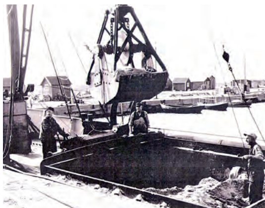
Nuvarande stenkaj byggs
